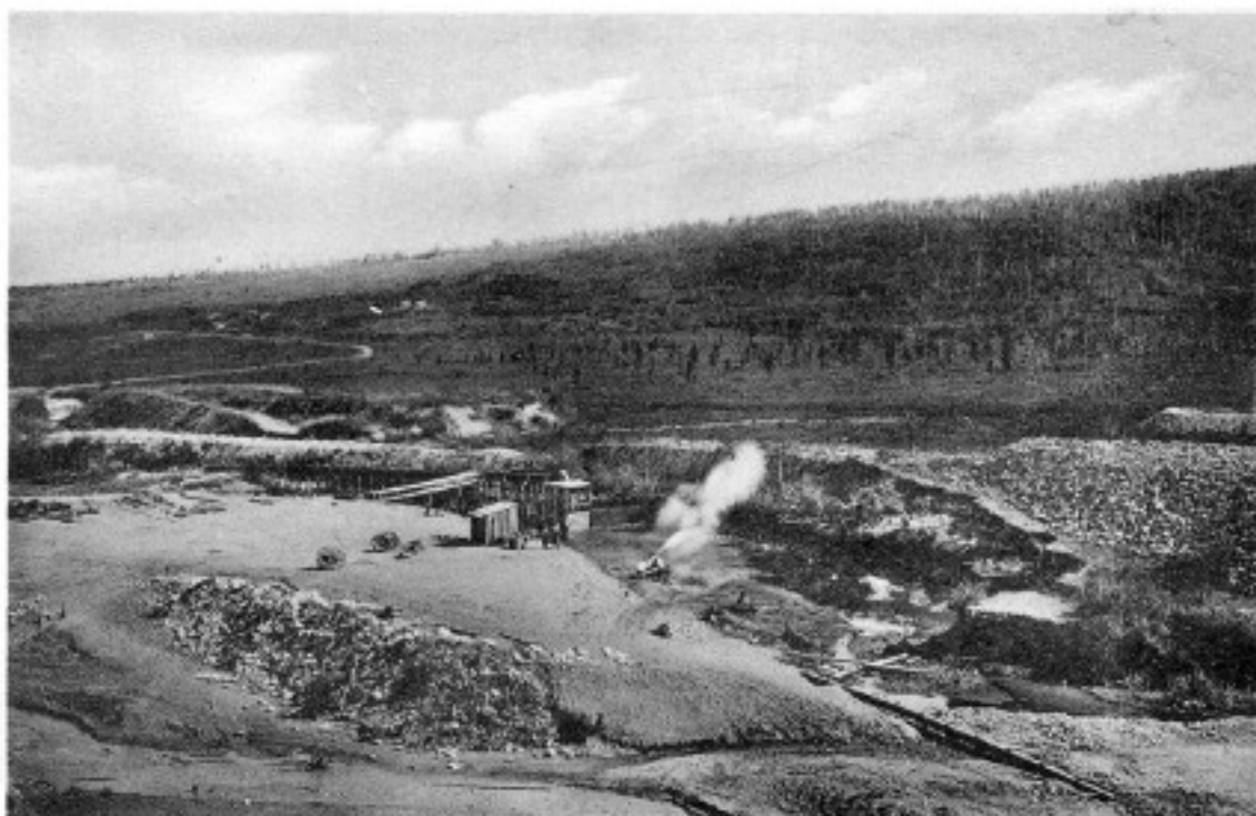
Зейскіе присковые виды. Примѣненіе гидравлическаго способа на прискахъ Верхне-Амурской золотопромы шленной Компаніи.
